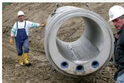
Canalisation préfabriquée avec échangeur de chaleur intégré.
