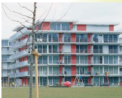
Le quartier de Wässerwiesen à Winterthur: les eaux usées permettent de chauffer 1000 habitants.
