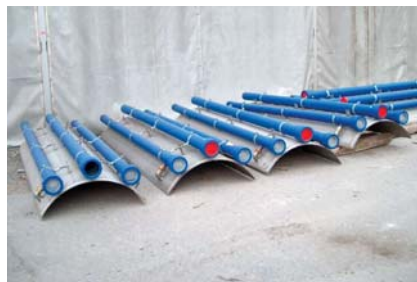
Echangeur de chaleur avant son installation dans une canalisation.
