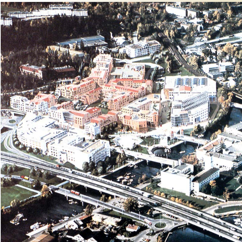
Le centre de Sandvika, alimenté en énergie à partir des eaux usées.
