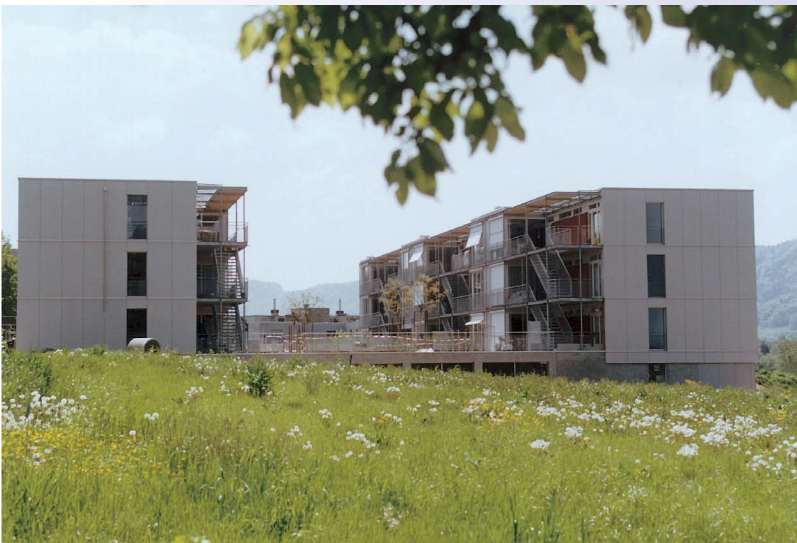
A Zurich-Wollishofen, un ensemble de 200 appartements profite de la récupération de la chaleur du réseau d'eau. Photo: ewz
