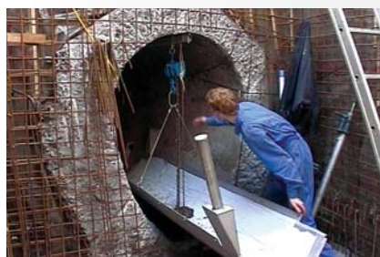
Pose d'un échangeur de chaleur dans une canalisation existante.
