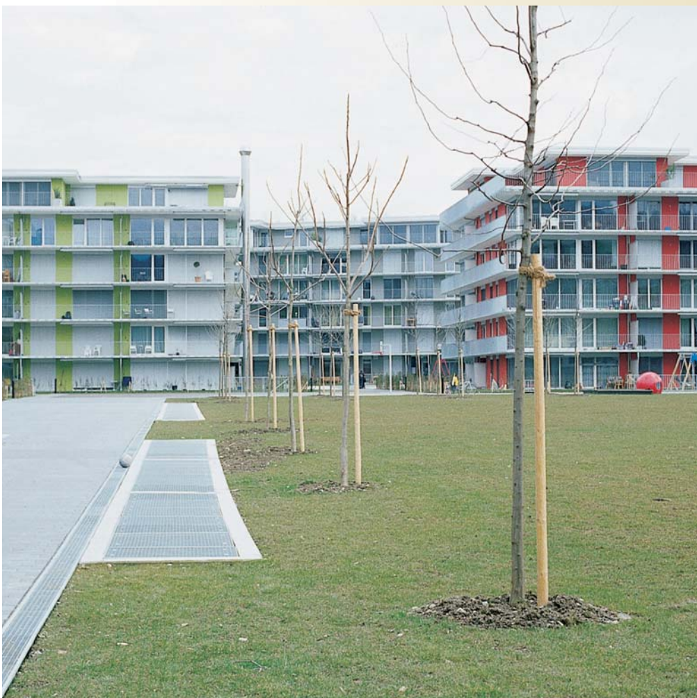
Dans le quartier de Wässerwiesen, à Winterthur, 400 appartements sont chauffés grâce aux eaux usées. Photo: L. Blazevic, tec21
