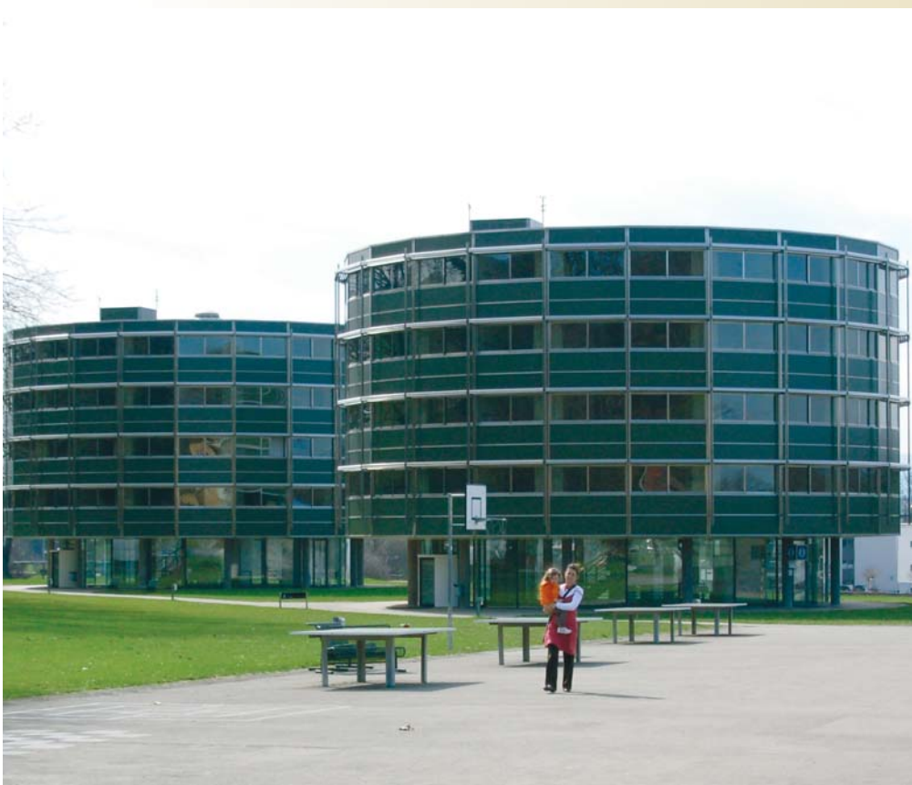
Le chauffage des deux pavillons abritant chacun 96 chambres individuelles est assuré par la récupération de la chaleur des eaux épurées.
