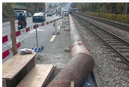
Déviations des eaux usées pendant les travaux.
