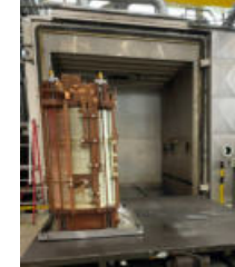
Récupération des pertes de chaleur
