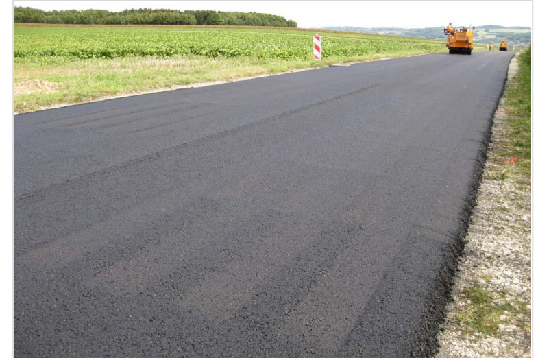
Source: Canton de Vaud (mise en œuvre d'un enrobé tiède)
